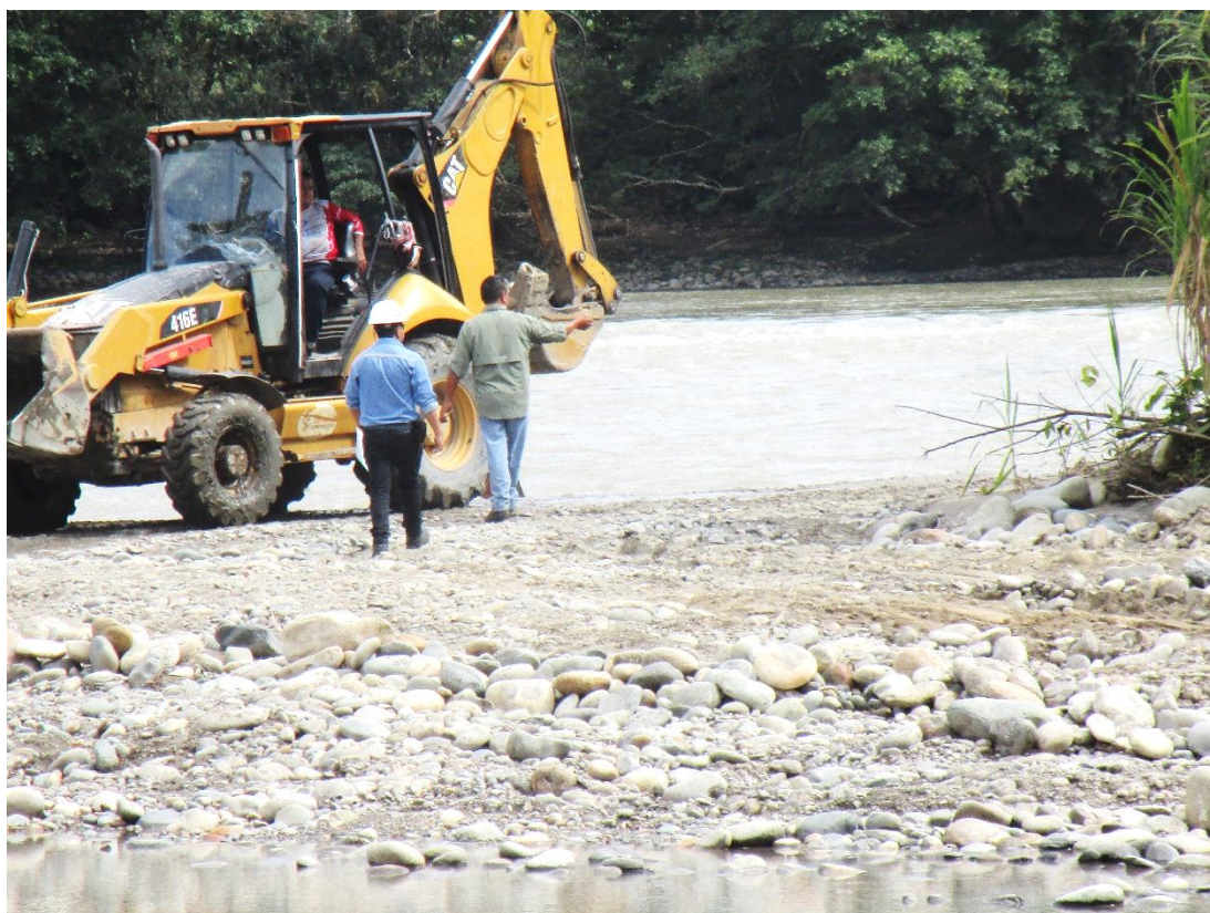
Figura 2. Inspección en campo.
