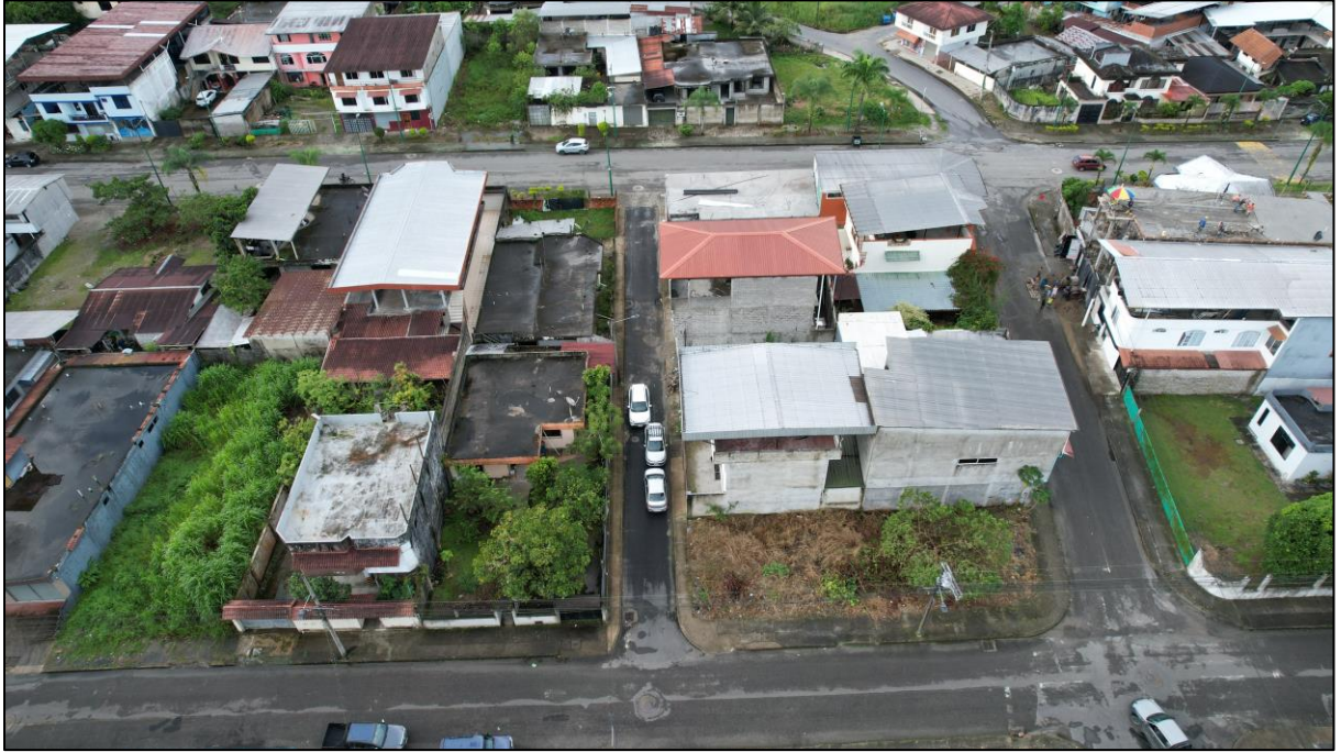
PASAJE S.N., ENTRE LA CALLE RUBÉN CEVALLOS Y AYAHUASCA
