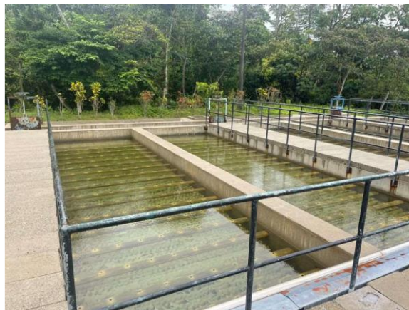
Fotografía 31: Sistema de Sedimentación
