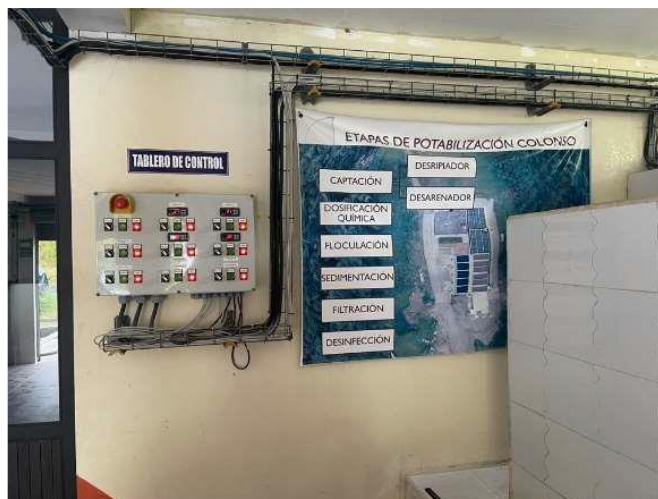
Fotografía 26: Tablero de control de bombas de dosificación.
