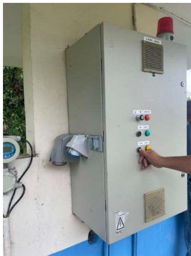
Fotografía 18: Tablero de control de desarenador
