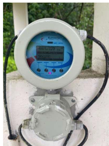
Fotografías 16 y 17: Macromedidor ubicado en la entrada de desarenador.
