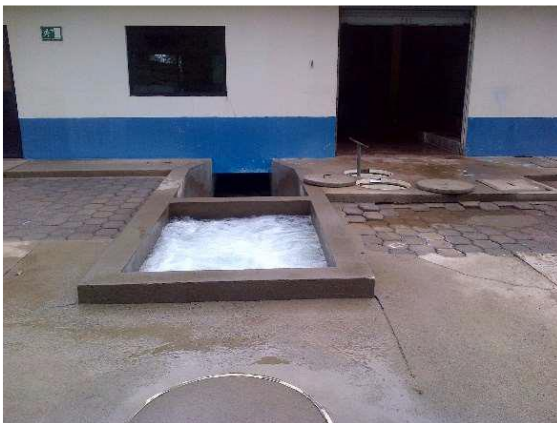
Fotografía 21: Ingreso a canal de dosificación
