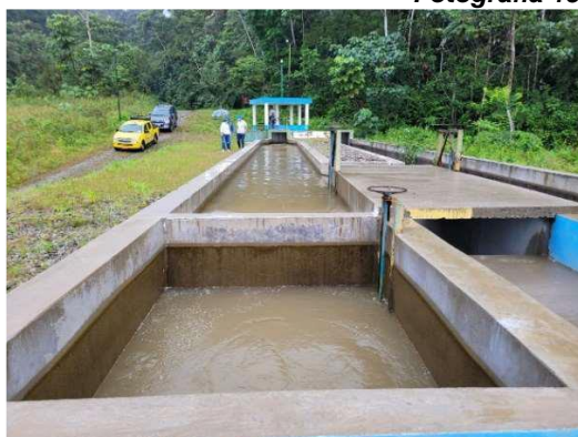
Fotografía 15: Desarenador
