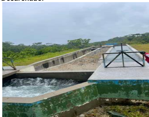
Fotografía 15: Desarenador
