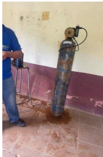
Fotografía 35: Sistema de cloración Fotografía 36: Disipador de Cloro Gas
