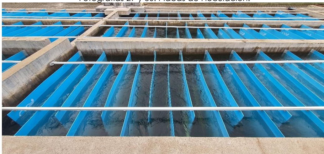
Fotografías 29 y 30: Placas de Floculación.
