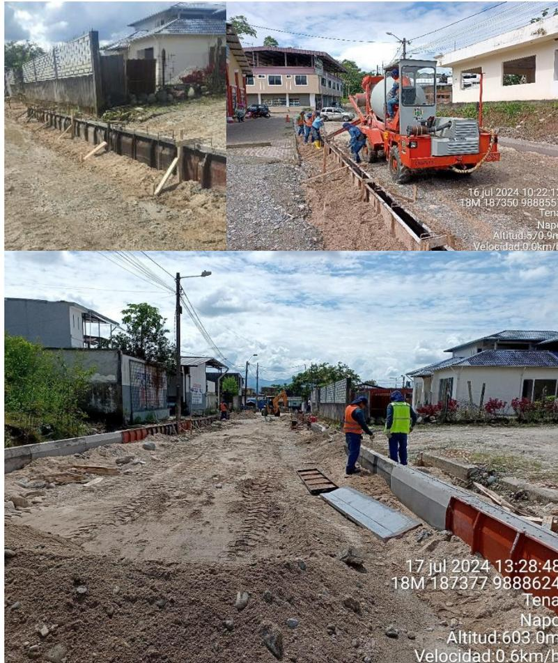
Imagen 6. Desencofrado de bordillos
