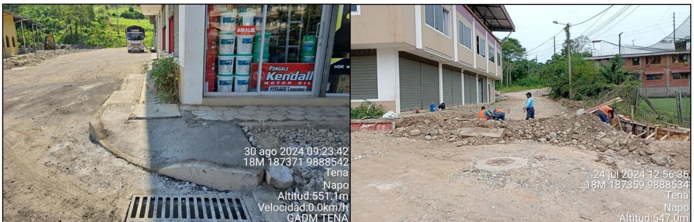
Imagen 5. Construcción de bordillo fin de vía (Berma)
