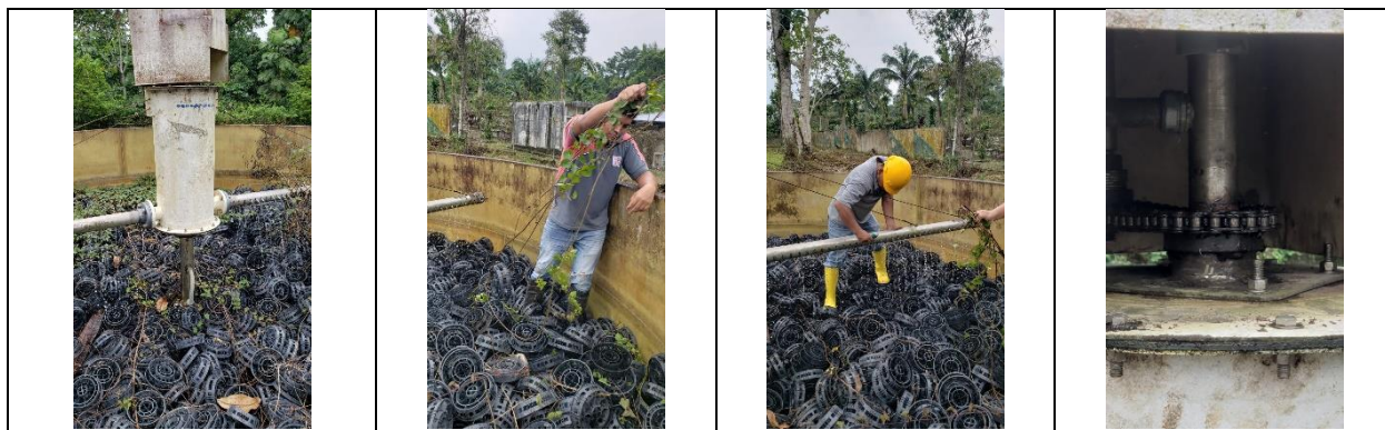
Figura 11. Mantenimiento de la cámara de filtros percoladores
