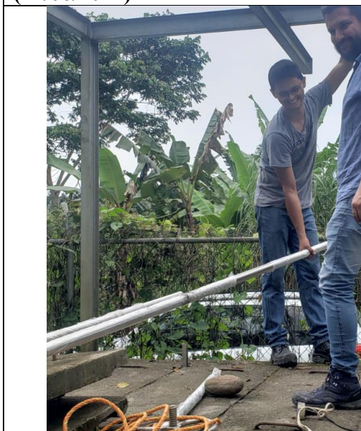
Entrega de dos tubos de acero inoxidable D=1 1/2 Pulg. Dd 6 metros cada uno en la bodega del GAD MUNICIPAL DE TENA (24/06/2024)
