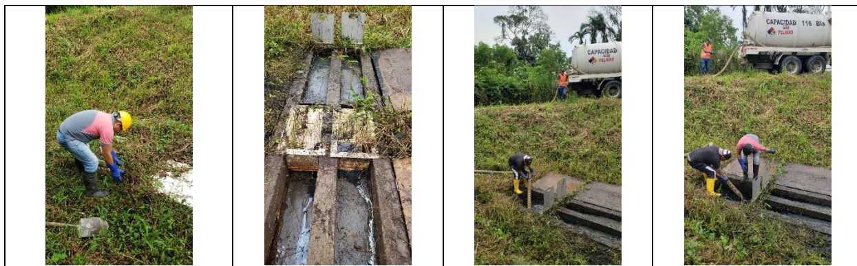
Figura 8. Mantenimiento del canal de entrada
