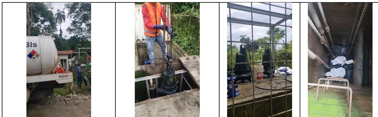
Figura 1. Vaciado del pozo y desinstalación de las bombas
