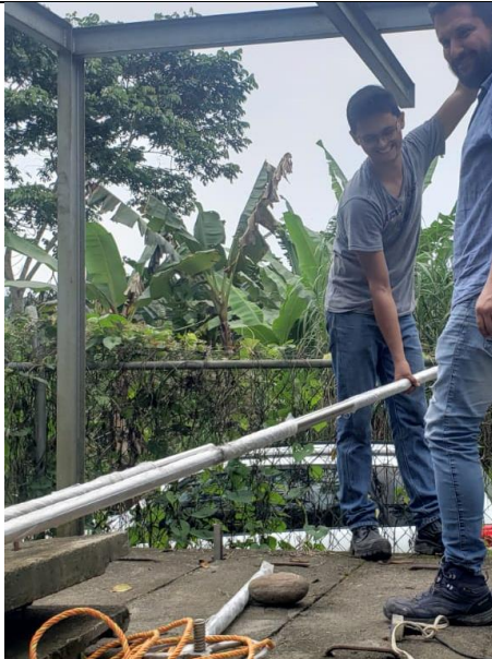
Entrega de dos tubos de acero inoxidable D=11/2Pulg. Dd 6 metros cada uno en la bodega del GAD MUNICIPAL DE TENA (24/06/2024)
