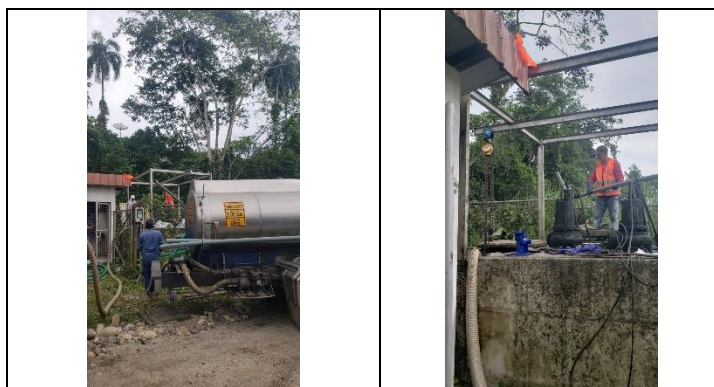
Figura 3. Limpieza del pozo con agua limpia
