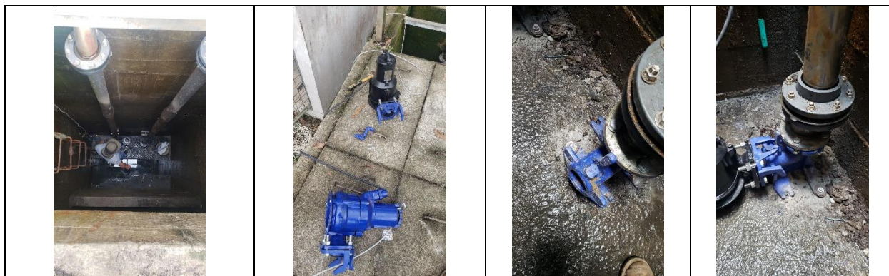
Figura 5. Instalación de bombas nuevas
