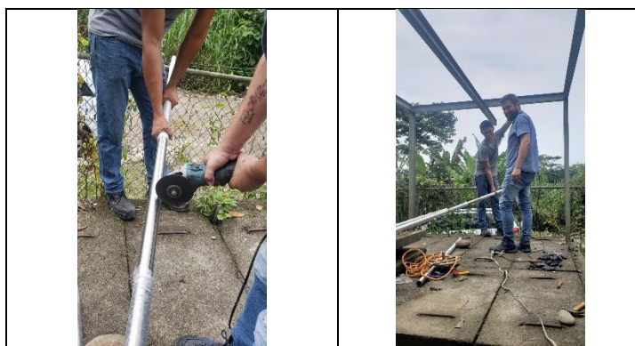
Figura 6. Instalación de los tubos ejes
